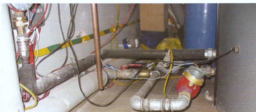
Fot. 1. Widok przepływomierza c.w.u. w trakcie montażu
