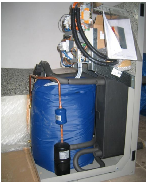
Rys. 3. Pompa ciepła Golf Maxi GMWW 38 bez obudowy zewnętrznej
