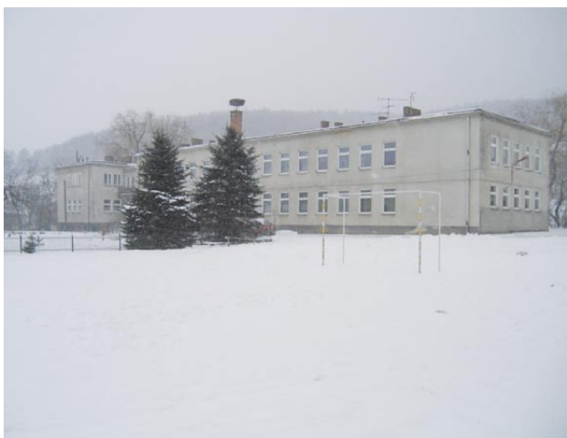
Rys. 1. Budynek Szkoły Podstawowej w Wielkiej Wsi
